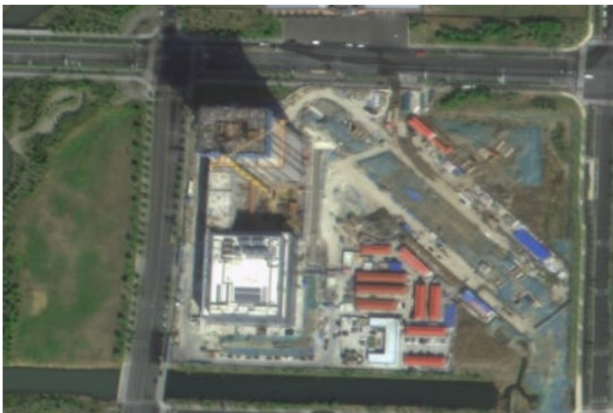
2022年（主体工程基本施工完毕）
