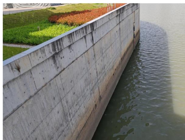
水闸上游翼墙混凝土老化
