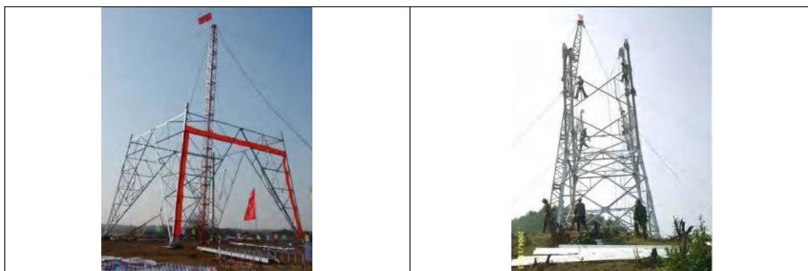
图1.1-3线路工程铁塔组装照片
