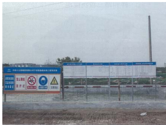
图 12 新建铁路宁启线南通至启东段项目钻孔桩泥浆池、沉淀池及防护
