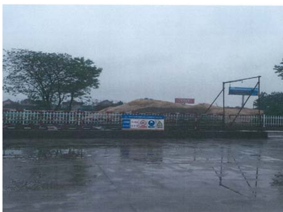
图 11 新建铁路宁启线南通至启东段项目拌和站三级沉淀池
