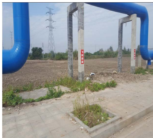
图 5 通州华电临时设施区土地平整
