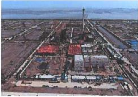
现场南侧俯视图
