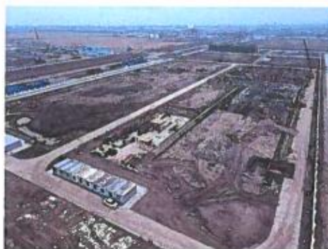
现场北侧俯视图
