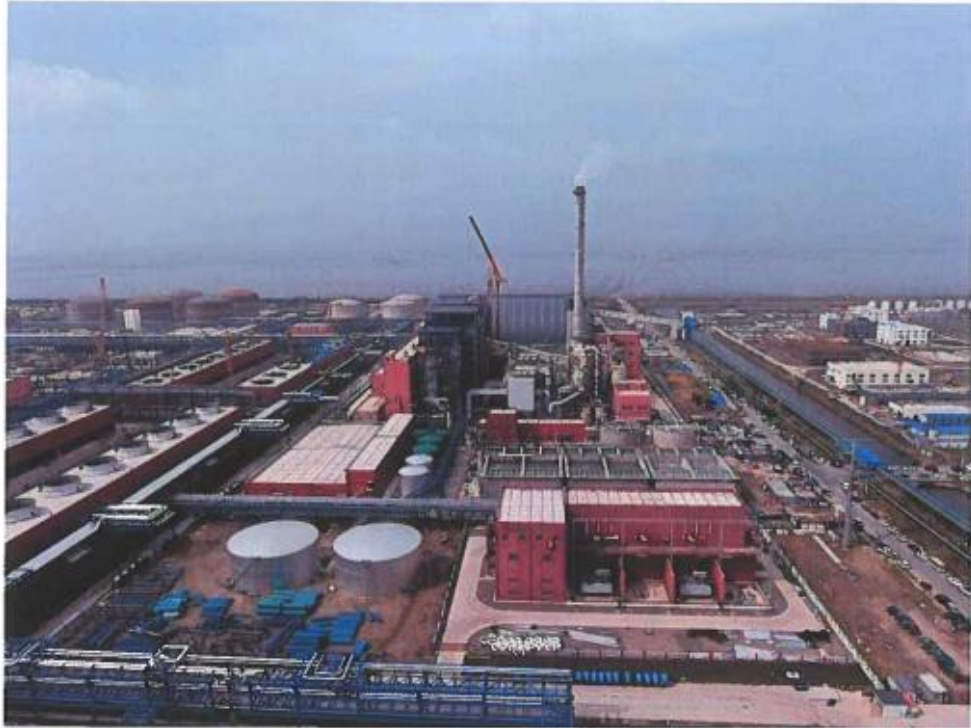
现场南侧俯视图
