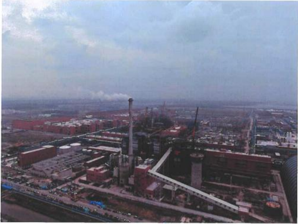
现场东侧俯视图
