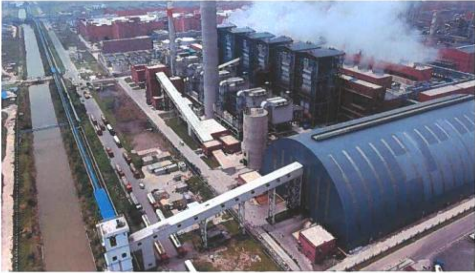
现场东北侧俯视图
