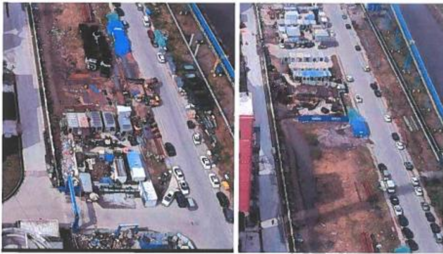
施工生产生活区
