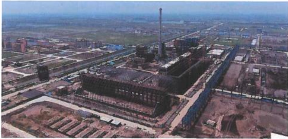
现场北侧俯视图
