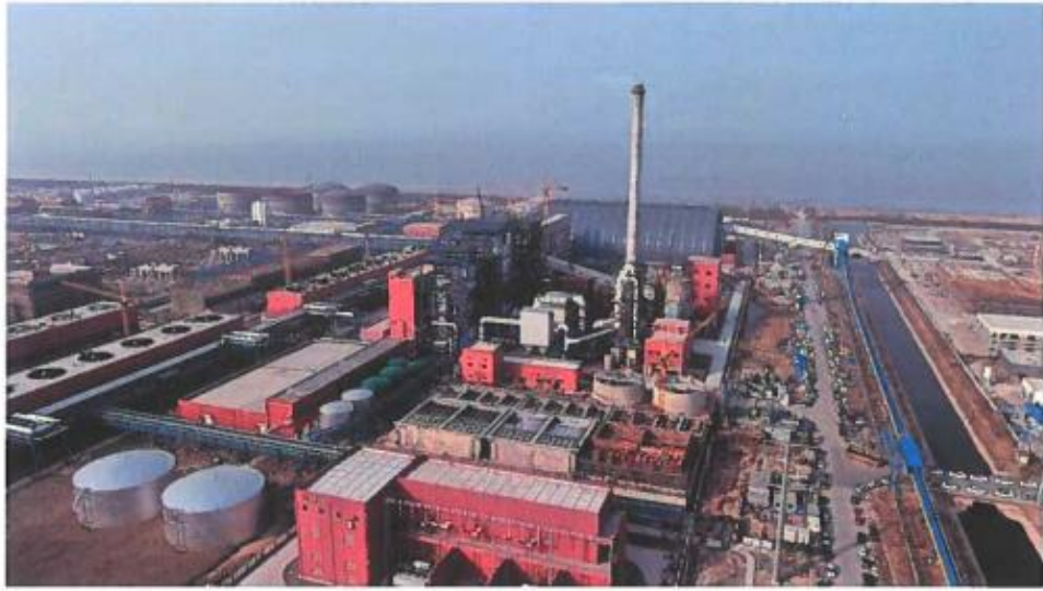
现场南侧俯视图
