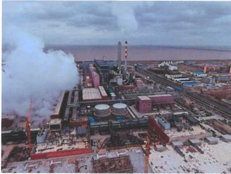
现场南侧俯视图
