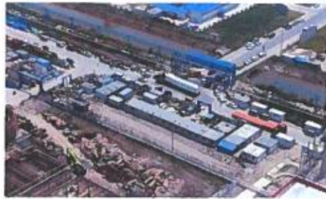
施工生产生活区
