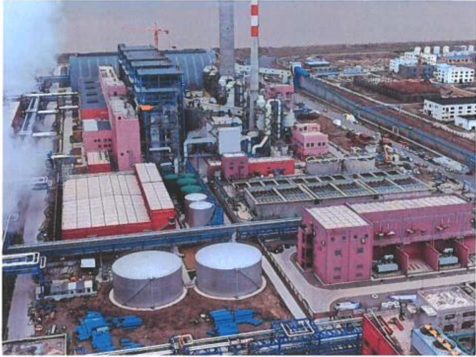
现场南侧俯视图
