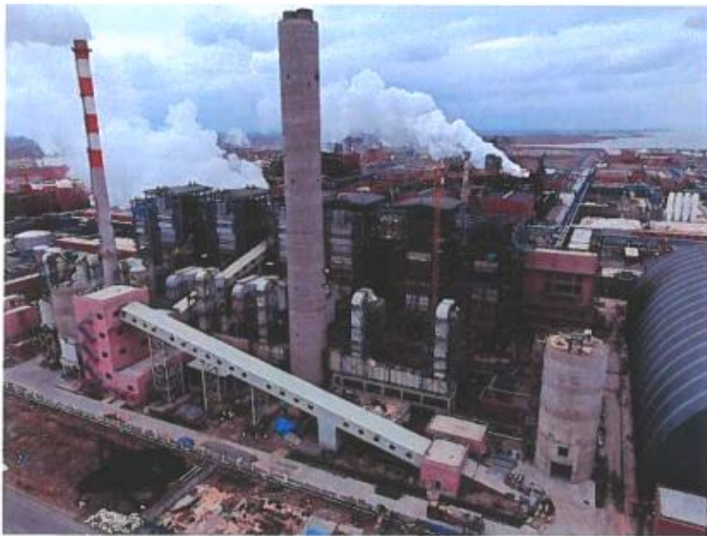
现场东侧俯视图
