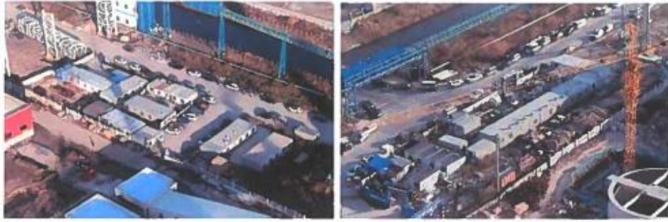
施工生产生活区
