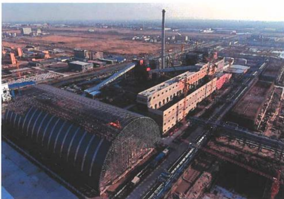
现场北侧俯视图
