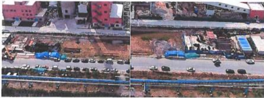
施工生产生活区
