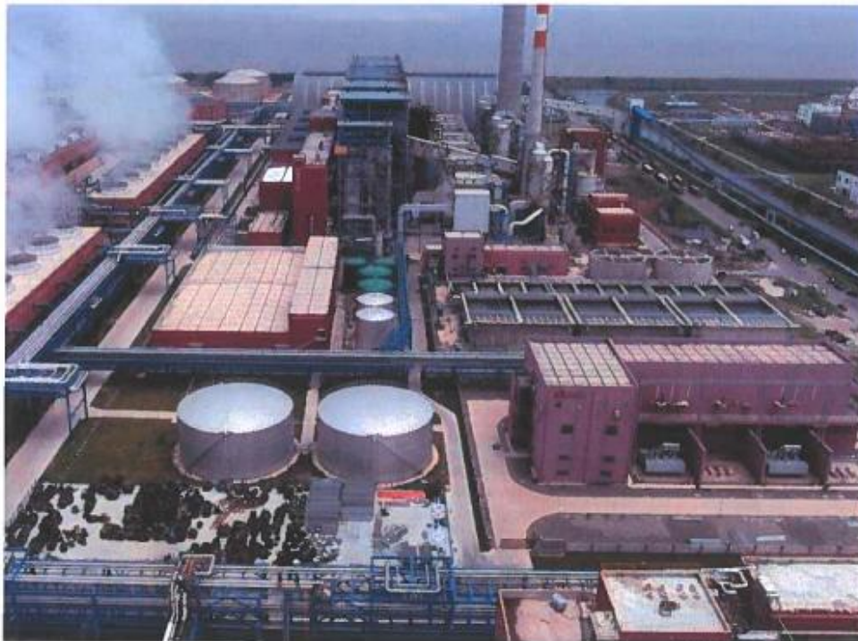
现场南侧俯视图
