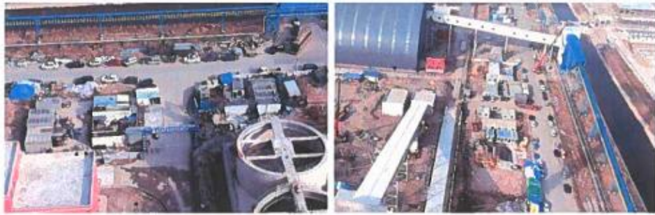
施工生产生活区
