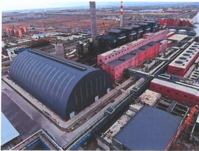
现场西北侧俯视图
